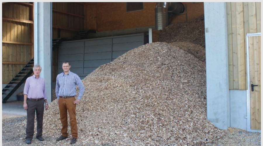
▲ Karl und Florian Sackmann zeigen gern die neue Holzverstromungsanlage
